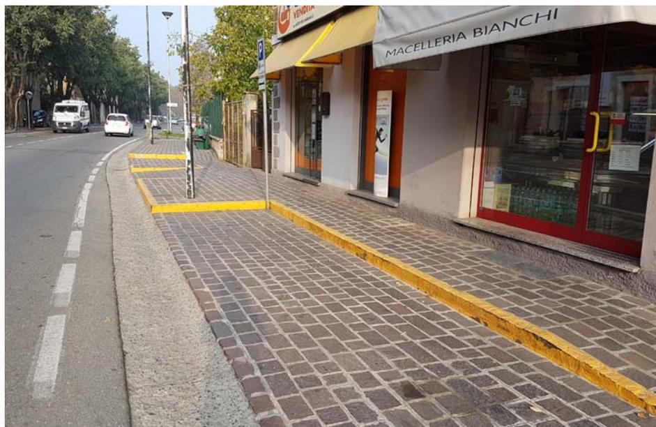
Segnaletica orizzontale gialla in prossimità di cambio di livello della pavimentazione esistente per ipovedenti
