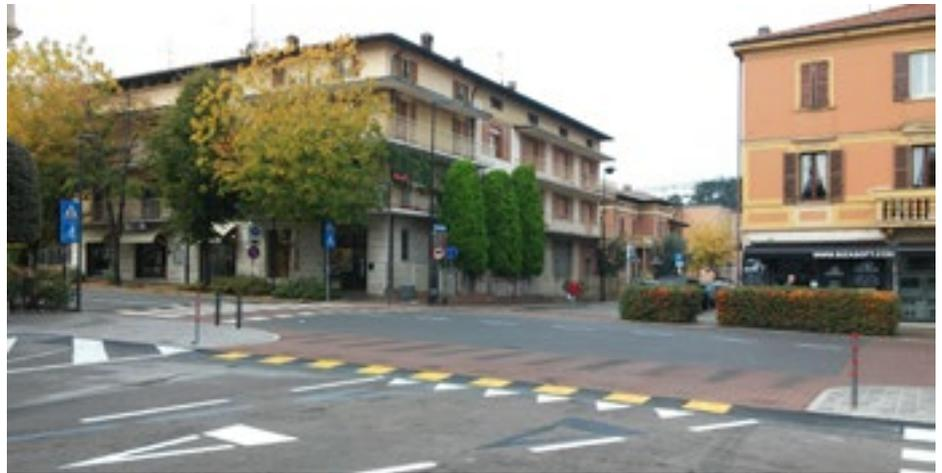
alizzazione di piattaforme rialzate necessarie per il rallentamento delle auto all'ingresso della zona in cui è stato istituito il limite dei 30 chilometri orari.
